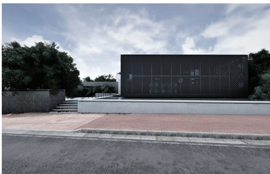
図3. CGによる瓦で織る壁 Woven Ceramic 施工シミュレーション
