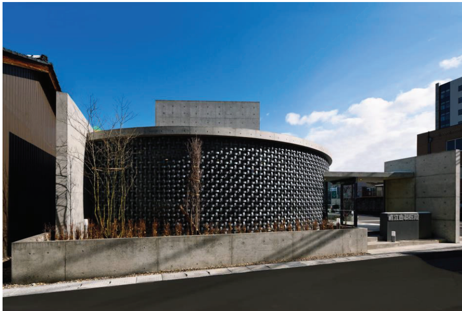
図1 製品化後の初の施工事例 (2020年2月、越前市)
